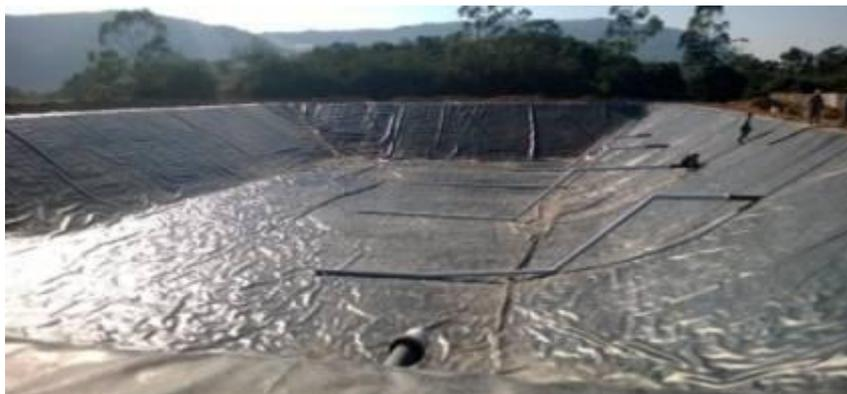
图 6.2-5 黑膜沼气池内部示意图
