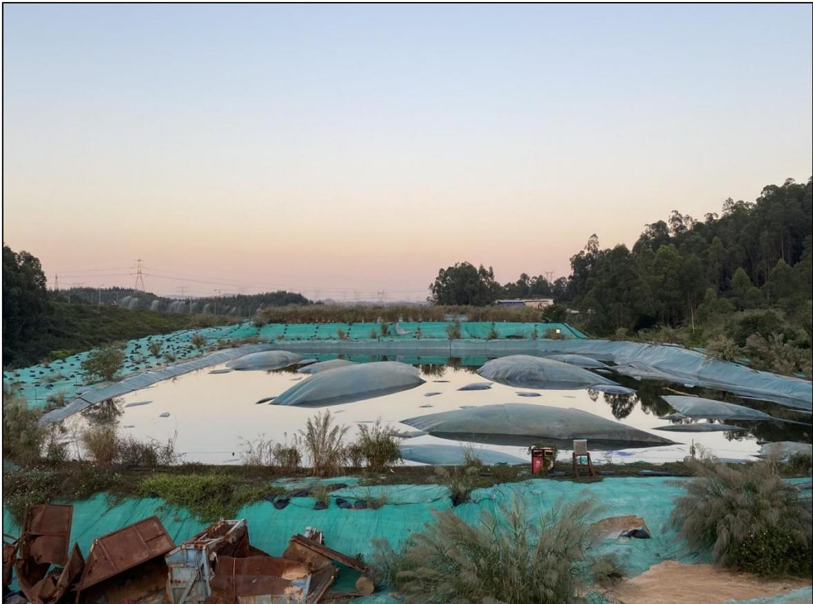
图 4.8-1 项目厂区内旗杆石垃圾填埋场渗滤液储存池（前期）
