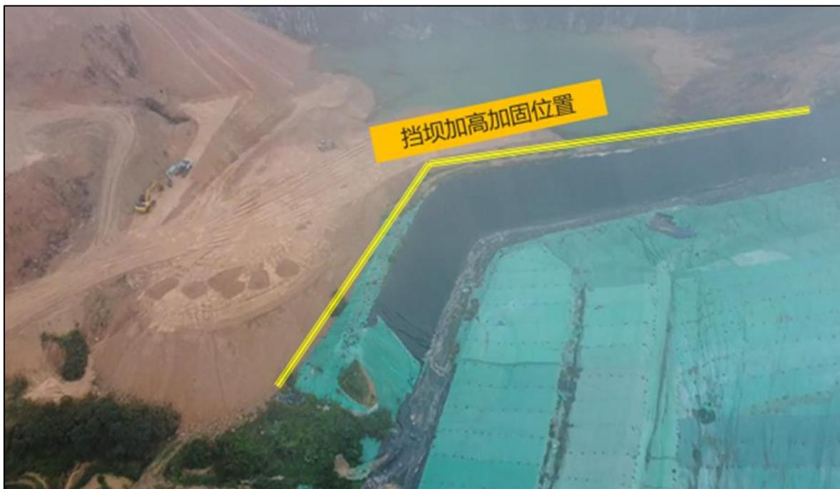
图 3.3-7 旗杆石生活垃圾填埋场坝体加高加固工程位置示意图（近景）
